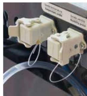
Connessioni elettriche per le sonde di umidità ZX.SU20 e temperatura ZX.ST20
